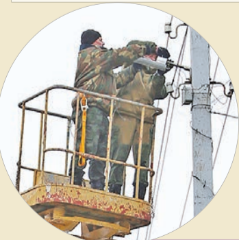
Электромонтеры УКП «Жилкомхоз» Михаил Сидоров и Дмитрий Гореликов устанавливают светодиодные фонари на одной из улиц города.
