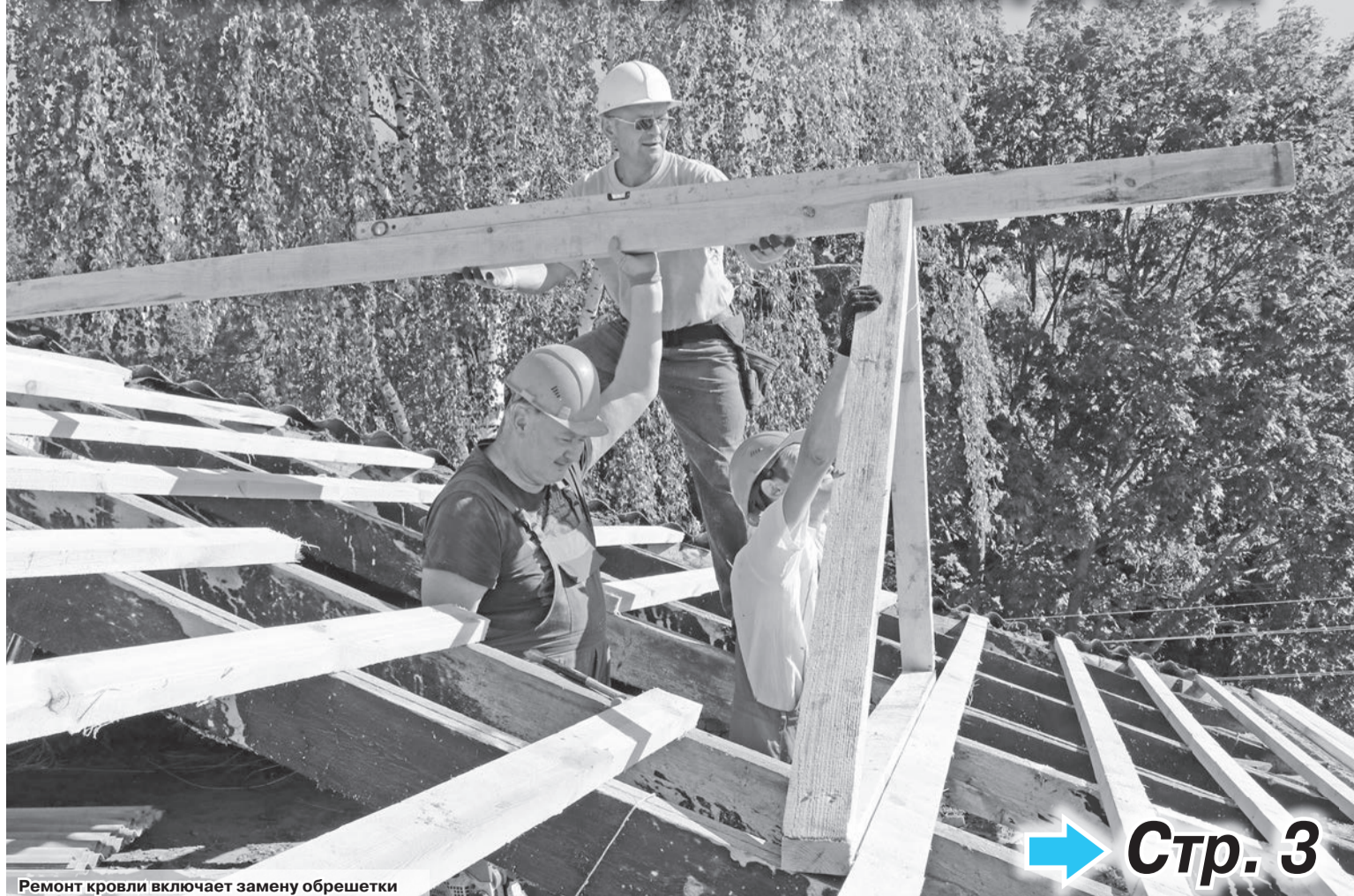
Ремонт кровли включает замену обрешетки
