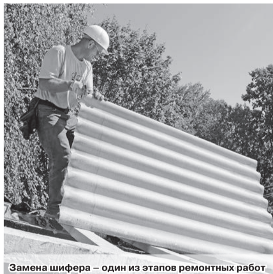
Замена шифера – один из этапов ремонтных работ
