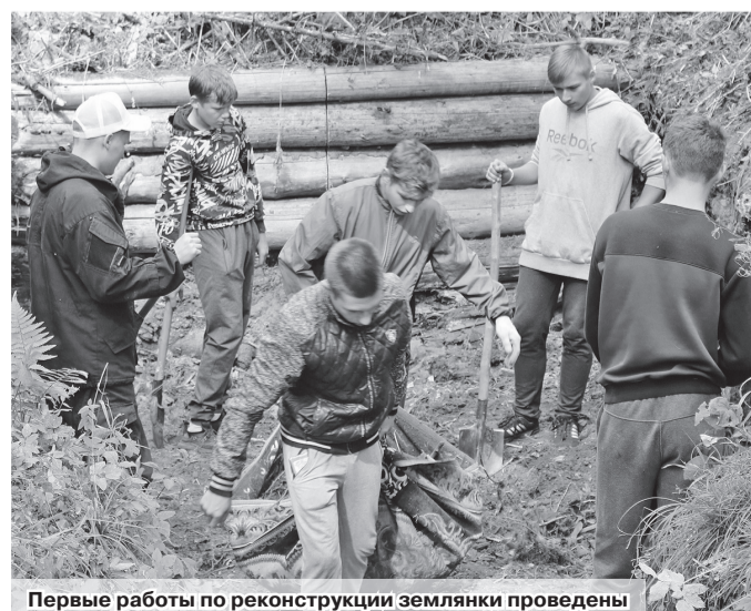
Первые работы по реконструкции землянки проведены
