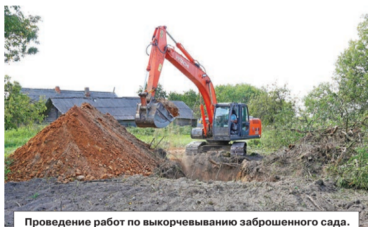
Проведение работ по выкорчевыванию заброшенного сада.
